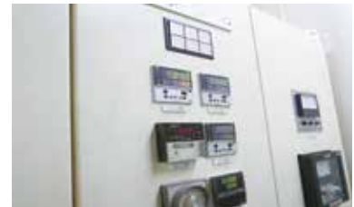
계장신호 측정에 % 표시 4-20mA / 0-20mA % 환산 표시
