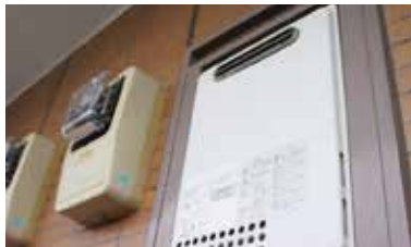
가스 연소장치의 미소전류측정에 DC \mu A 레인지 DT4253 만 해당
