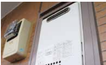
가스 연소장치의 미소전류측정에 DC μA 레인지
