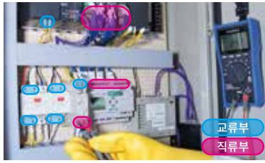
직류, 교류 전압이 혼재된 측정장소에서 측정을 자동으로 전환
